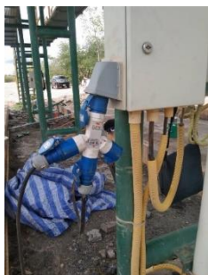
อุปกรณ์ต่อพ่วงที่นำมาใช้งานเป็นชนิด พาวเวอร์ปลั๊กทุกตัว
