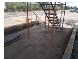
น้จรมมีโครงสร้างที่แข็งแรง มีบันไดเหล็กสำหรับขึ้น-ลง ใช้แผ่นเหล็กสำหรับรองยืนที่ได้มาตรฐาน
