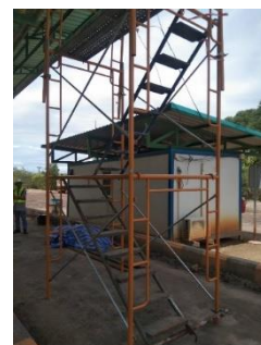
น้จรมมีโครงสร้างที่แข็งแรง มีบันไดเหล็กสำหรับขึ้น-ลง ใช้แผ่นเหล็กสำหรับรองยืนที่ได้มาตรฐาน
